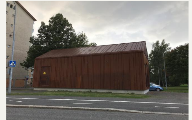
Kuva: Esimerkki sähkösyöttöasemasta Tampereen raitiotien osalta 1.
